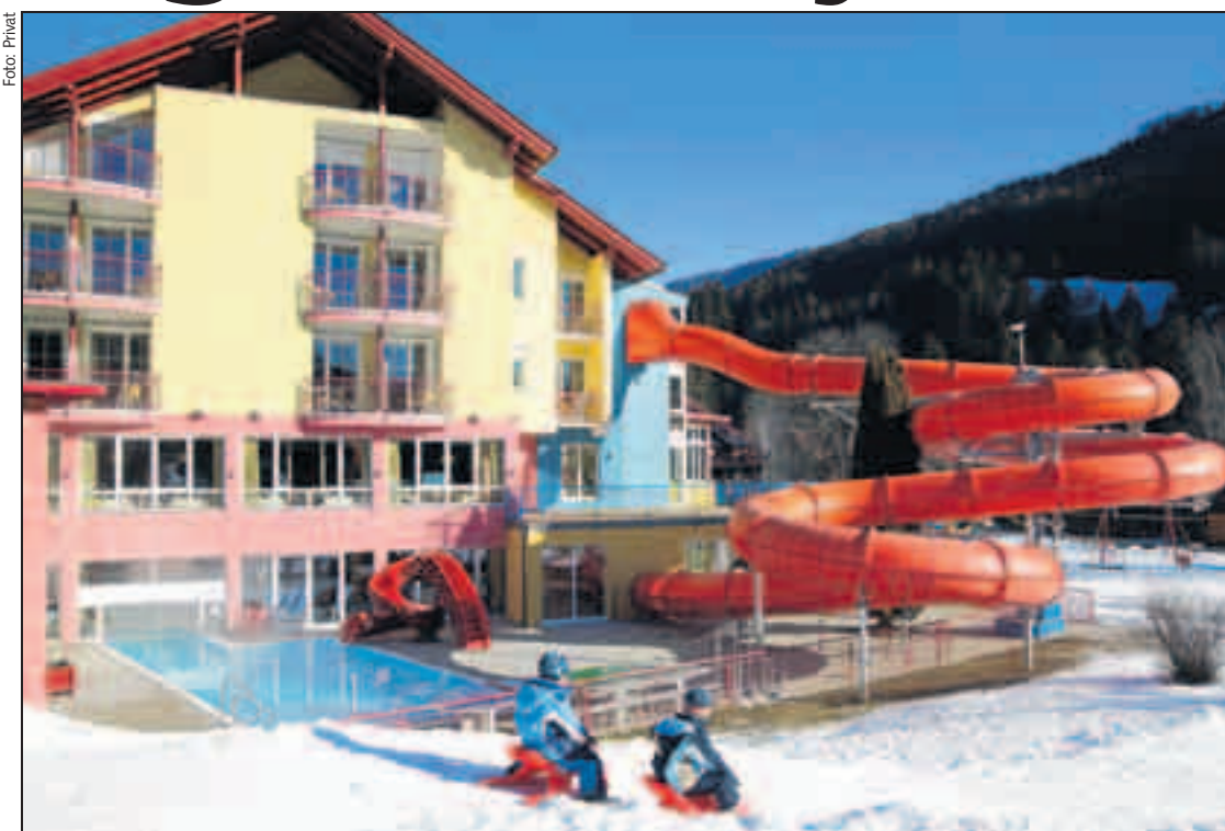
Der größte „Energieverbraucher“ des 1. Babyhotels: Der ganzjährig beheizte Outdoorpool
